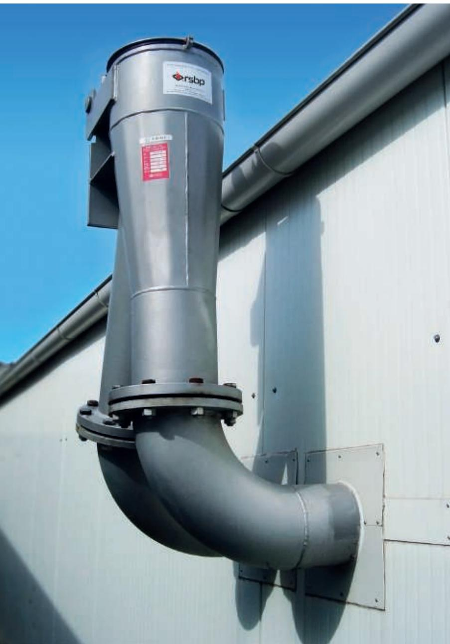
При нормальной эксплуатации взрывоотвод является составной частью трубопровода. Поток материала во взрывоотводе поворачивается и направляется дальше по трубопроводу. В аварийном состоянии взрывоотвод служит в качестве функции безопасности и направляет распространение взрыва по трубопроводу в безопасную зону.
